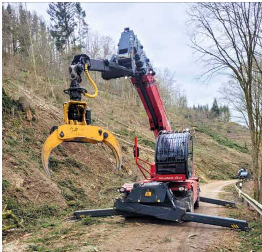
Spezialfällkran, Magni bei Obereisenbach. © LP
