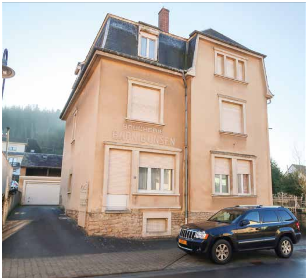
Fassade vor der Renovierung.
