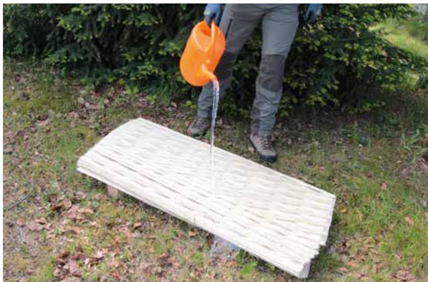
Die Hülle wird flach geliefert und vor der Montage gut gewässert – die Furniere werden so sehr biegsam. Fotos: M.Reetz
