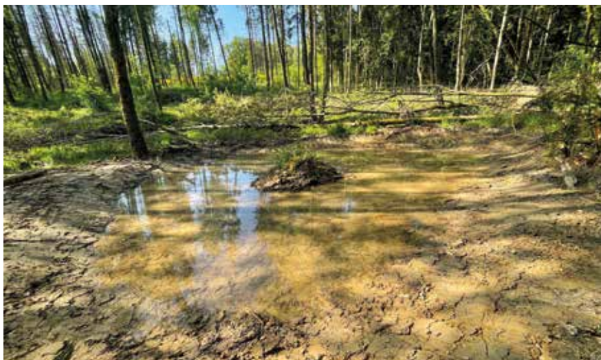
Anlegen von Mardellen im Wald, unmittelbar nach der Fertigstellung © Marc Schmit
