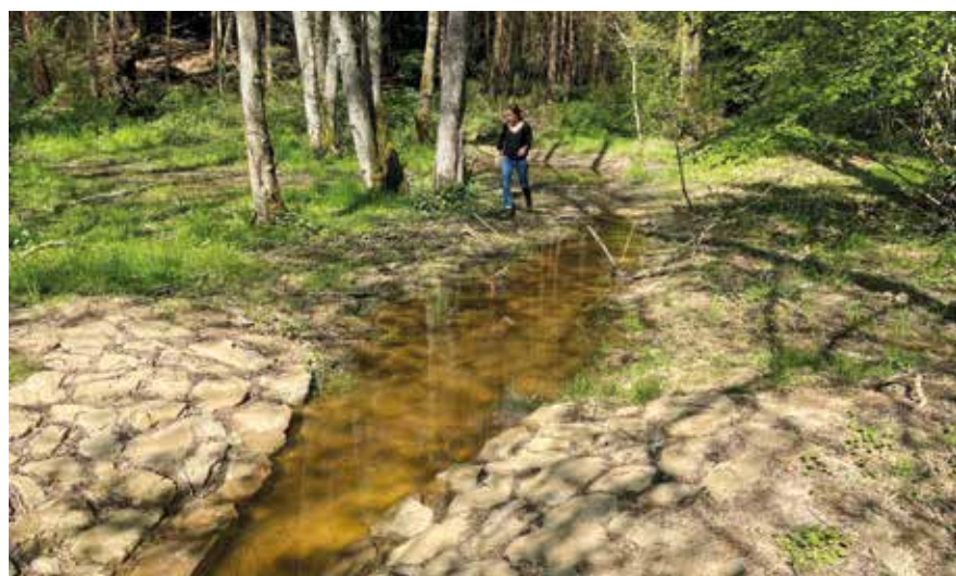
Bau einer Furt zur Wiederherstellung der Durchgängigkeit © Marc Schmit
