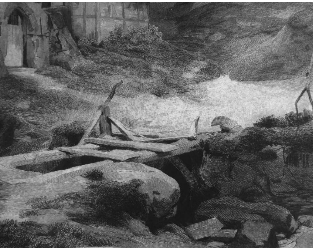
Detail Brücke © W. von Abbema
