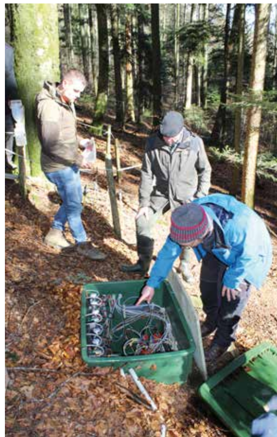
Auffangbecken für Regenwasser
