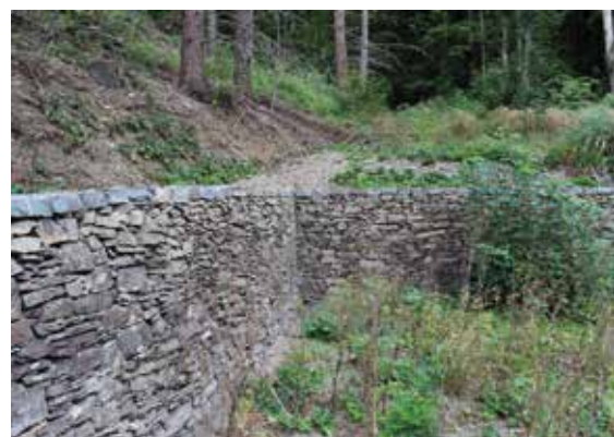
Foto Trockenmauer nach der Restaurierung 2019
