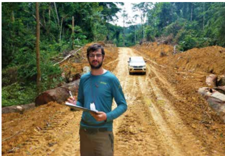
Figure 4: Pendant les relevés des données sur une route secondaire en construction pour la saison des pluies.
