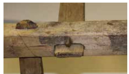
Simple Keilverbindung aus Holz
