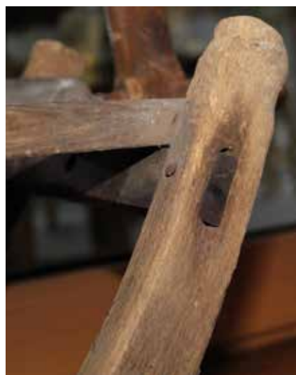
Faserverlauf im Schlitten
